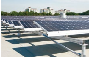
건물옥상형 Flat Roof Mounted Type / Mái nhà
