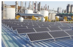
무타공지붕형 Non perforated Rooftop Mounted Type Loại mái không đục lỗ
